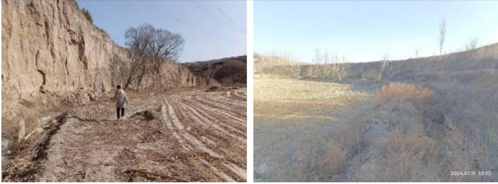
图 3-4 部分河段顶冲部位存在冲刷现象
